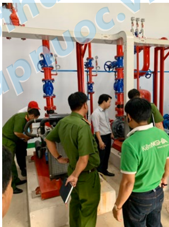
Máy bơm điện rời trực với motor /Electrical Drive Pump Motor: ATT - SINGAPORE 120HP/90KW
