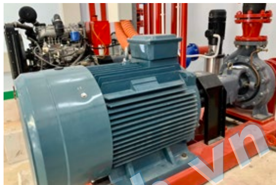
Máy bơm điện rời trực với motor /Electrical Drive Pump Motor: ATT - SINGAPORE 120HP/90KW
