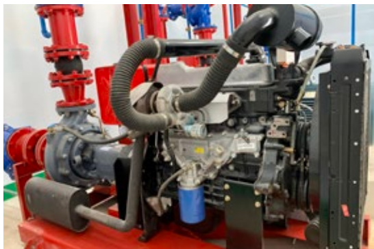
Máy bơm rời trực với Động cơ Diesel /Diesel Engine Drive Pump Engine: HYUNDAI - KOREA 130HP/97W
